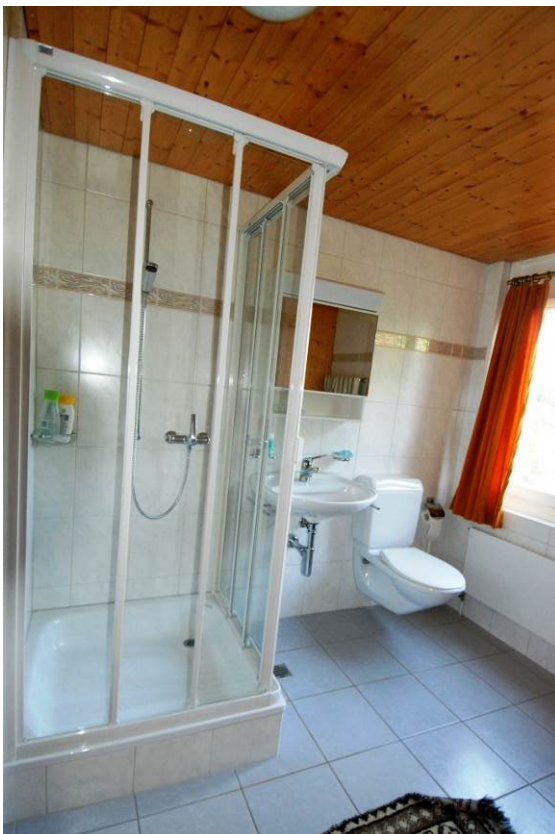
Sanitäre Anlagen im 2. Untergeschoss
